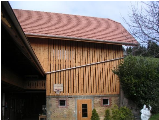
Paroi à claire-voie du pont de grange
