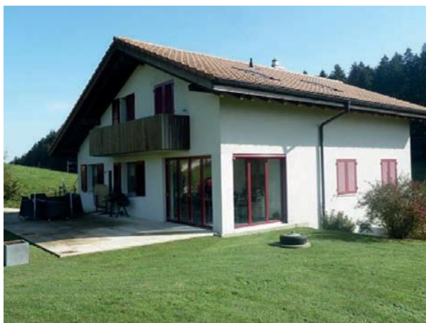
Vitrage d'un renforcement de bâtiment
