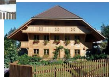
Reconstruction d'une petite ferme après sa démolition
